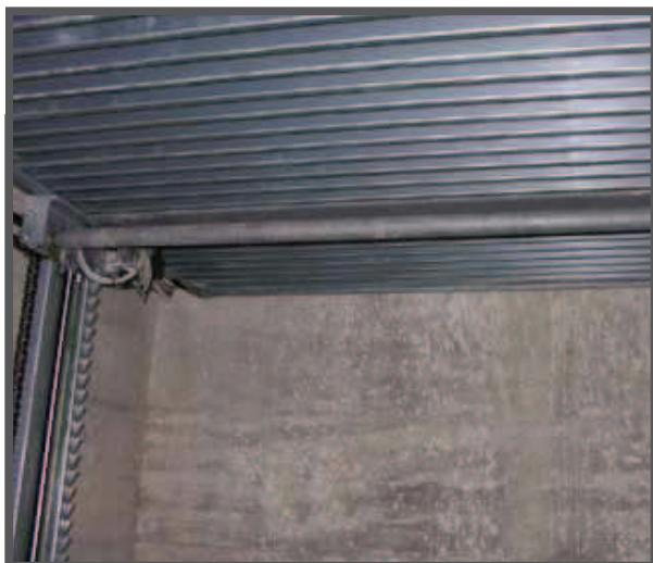
La machine est équipée de deux barres de torsion, une pour chaque paire de colonnes, situées sur ses bords. Les barres de torsion, dans ce cas, font partie du système de chaînes qui permettent d'aligner la machine de manière parfaite, et empêchent toute inclinaison.
